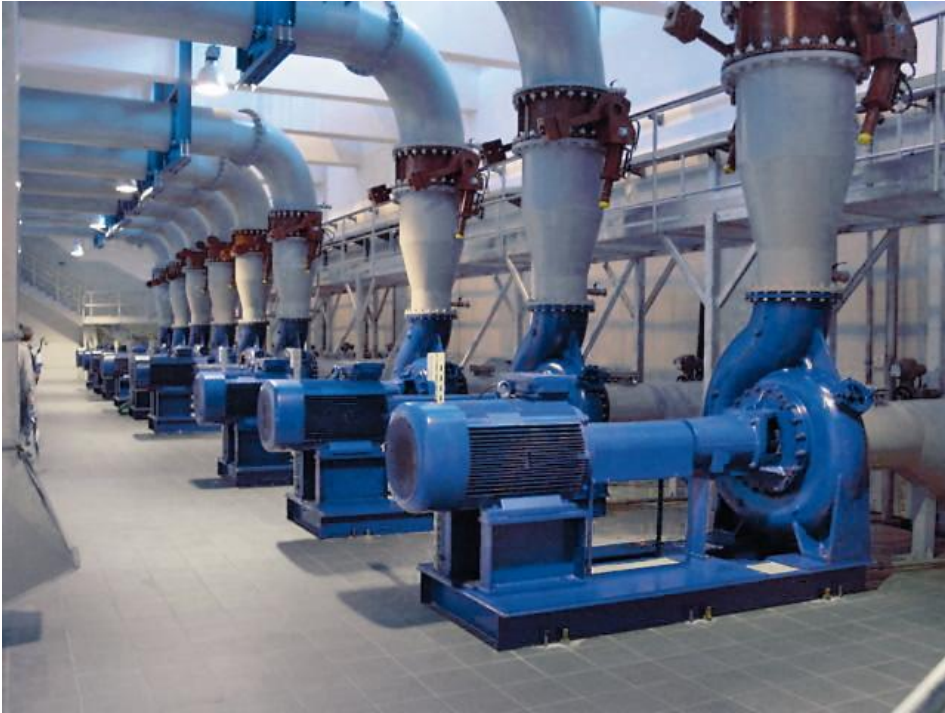
Kreiselpumpen in einem Wasserwerk https://commons.wikimedia.org/wiki/File:Kreiselpumpen_im_Wasserwerk.jpg
