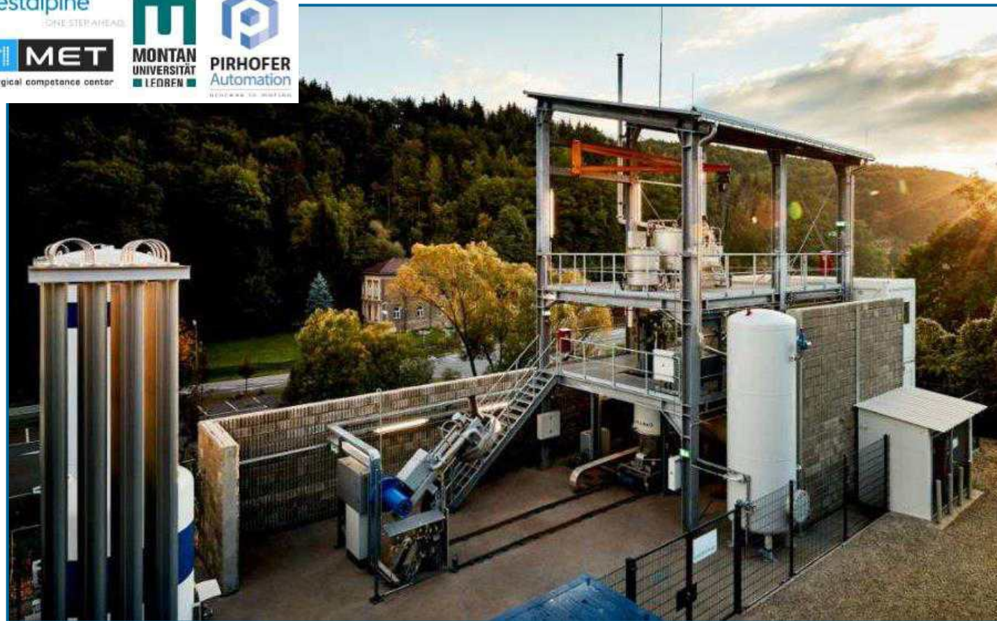
HPSR Pilotanlage in Donawitz (© K1-MET GmbH)
